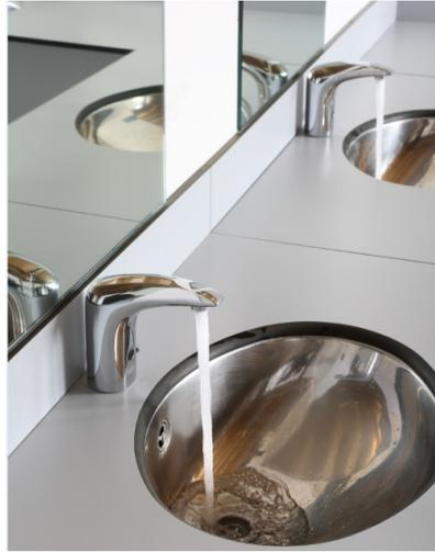
Inoltre per i lavabi dei bagni sono stati installati i miscelatori elettronici **02515**. Uno dei punti forti di questo prodotto è **il sistema antilegionella**, che eroga automaticamente un flusso d'acqua ogni **24 ore per evitare il ristagno** dell'acqua e la proliferazione di batteri.
